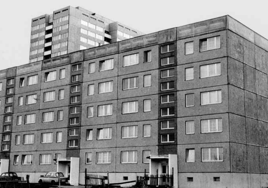
Poelchaustraße 34-44 (Erstbezug November 1978) vor und nach der Modernisierung
